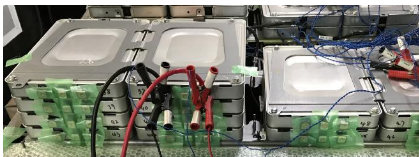
写真 3.2.3 パート No.4 単モジュール放電の様子
