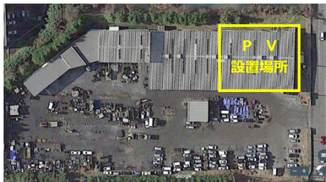
写真 2.2.1 株式会社啓愛社 栃木リサイクルセンター（Google Earth を利用）
