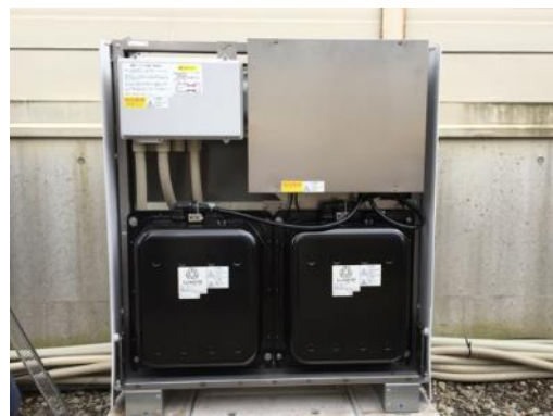
写真 2.2.7 LiB 蓄電池 (2) 内部構造
