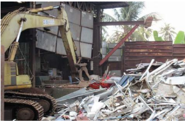
重機で鉄スクラップをプレス機へ投入している様子
