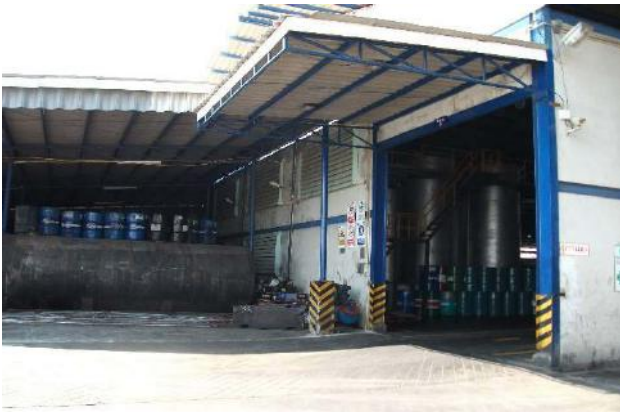
同社敷地内の様子 (右手は引取後のエンジンオイル保管タンク)
